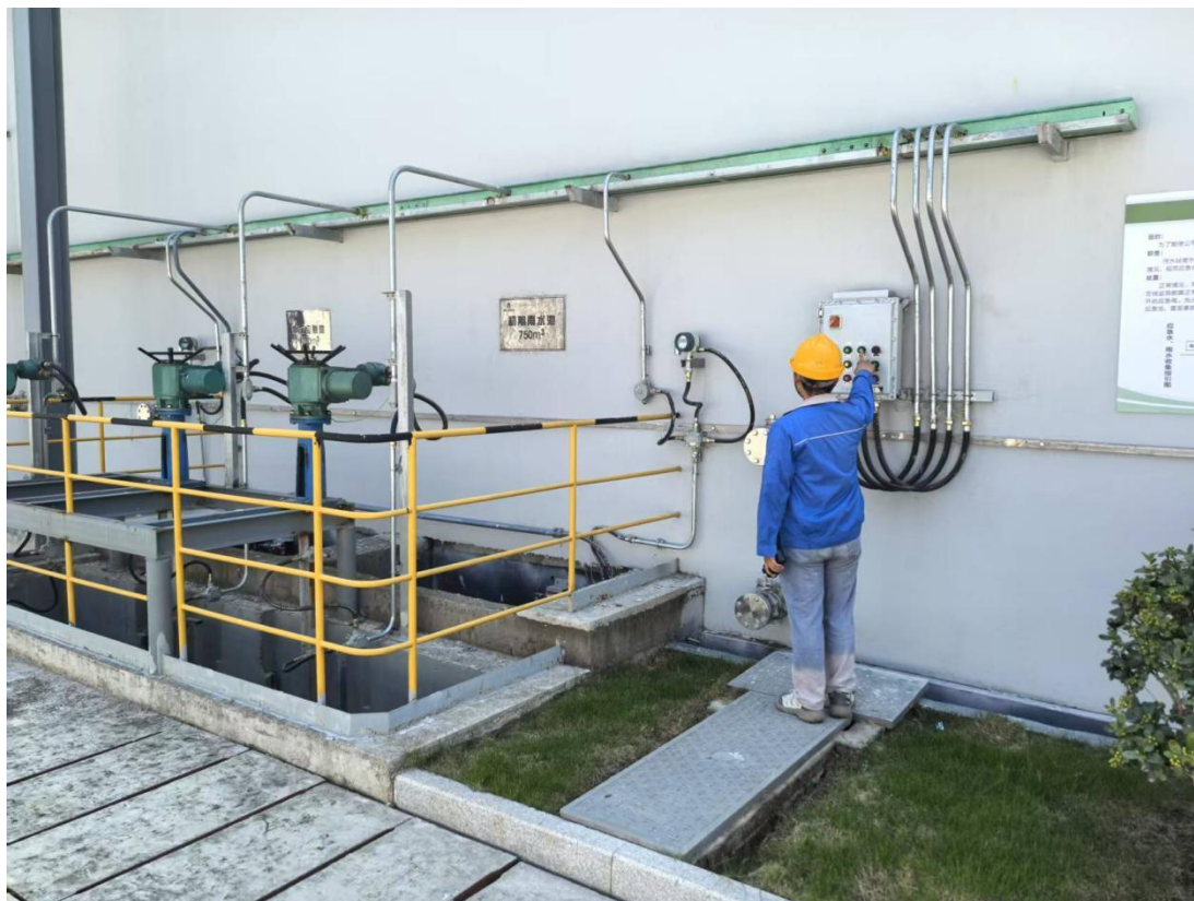
确认雨水阀门关闭
